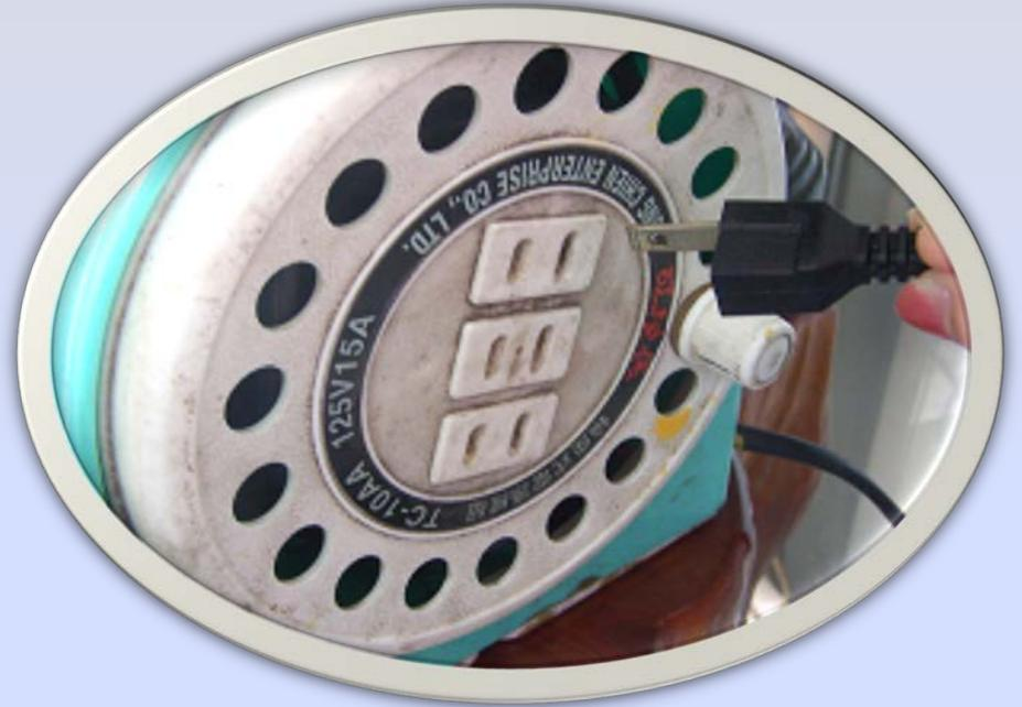
\*請先以檢電筆測試出地線孔。
